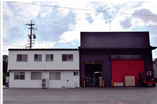
平成29年に稼働した膝折工場
