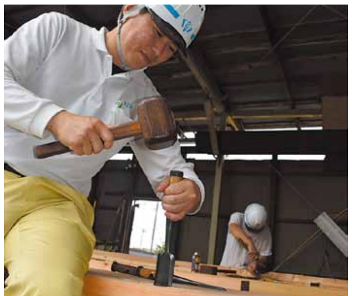
鑿（のみ）で仕口を仕上げる
