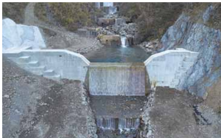
ICT施工によって完成した現場
